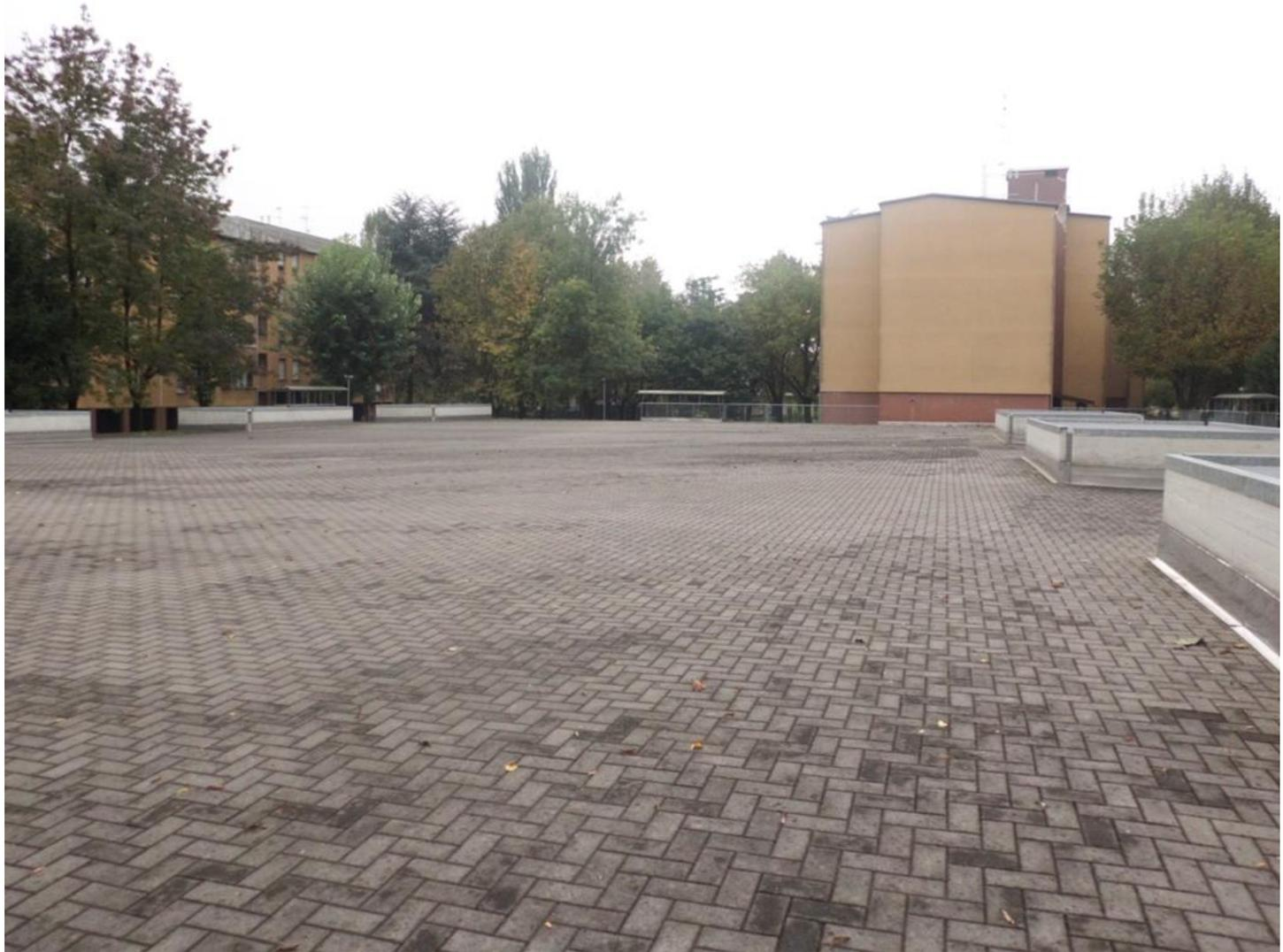
Descrizione: nel parcheggio si trovano 6 condotti di areazione per permettere di far circolare l'aria nel parcheggio sotterraneo.
